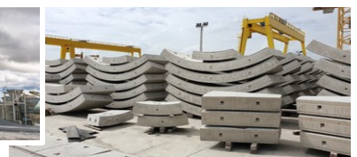
โรงงานผลิตชิ้นส่วนคอนกรีตสำเร็จรูป
